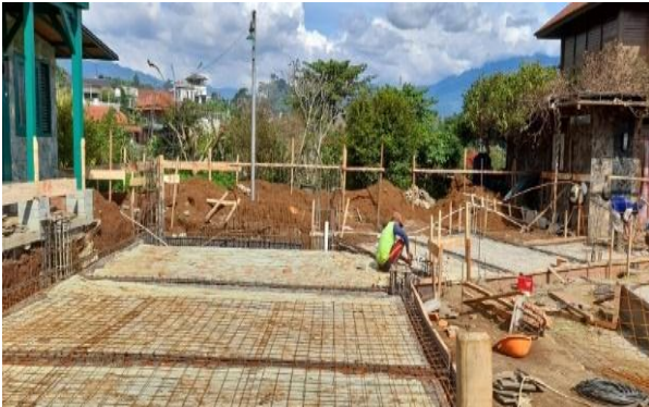
Gambar 3. Kondisi Progress Mingguan Proyek
