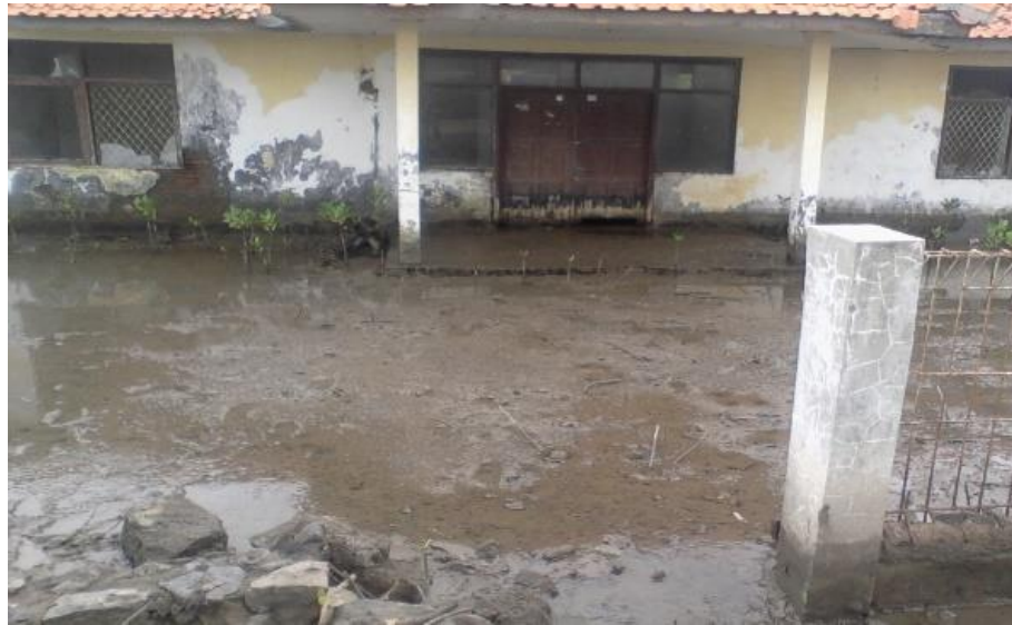
Gambar 2. Kerusakan Perumahan Sumber: Hasil Observasi
