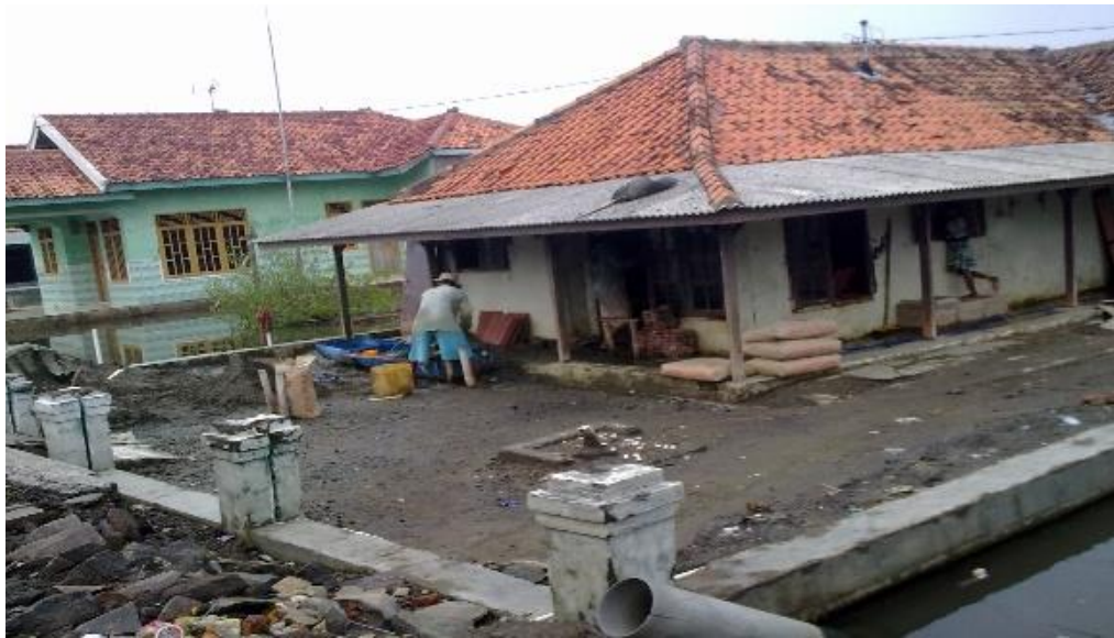
Gambar 5. Relokasi Bangunan Sumber: Hasil Observasi
