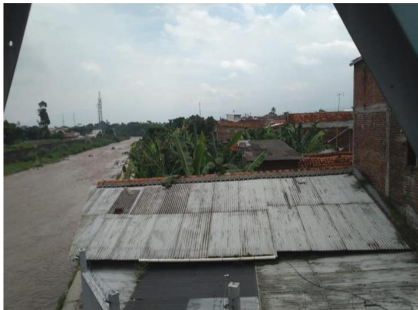
Gambar 6. Foto Atap Rumah Penduduk Sumber: Dokumentasi Penulis 2021
