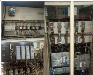
Gbr 10. Rangkaian Sistem Kendali Kontrol Kapasitor bank
