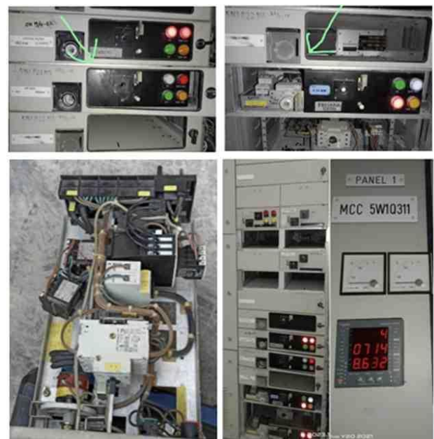
Gbr 15. Modifikasi starter Reversible di panel MCC
