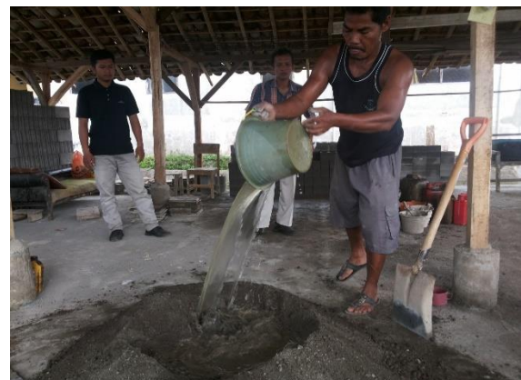
Gambar 6. Pencampuran bahan pasir, abu batu, semen dan air
