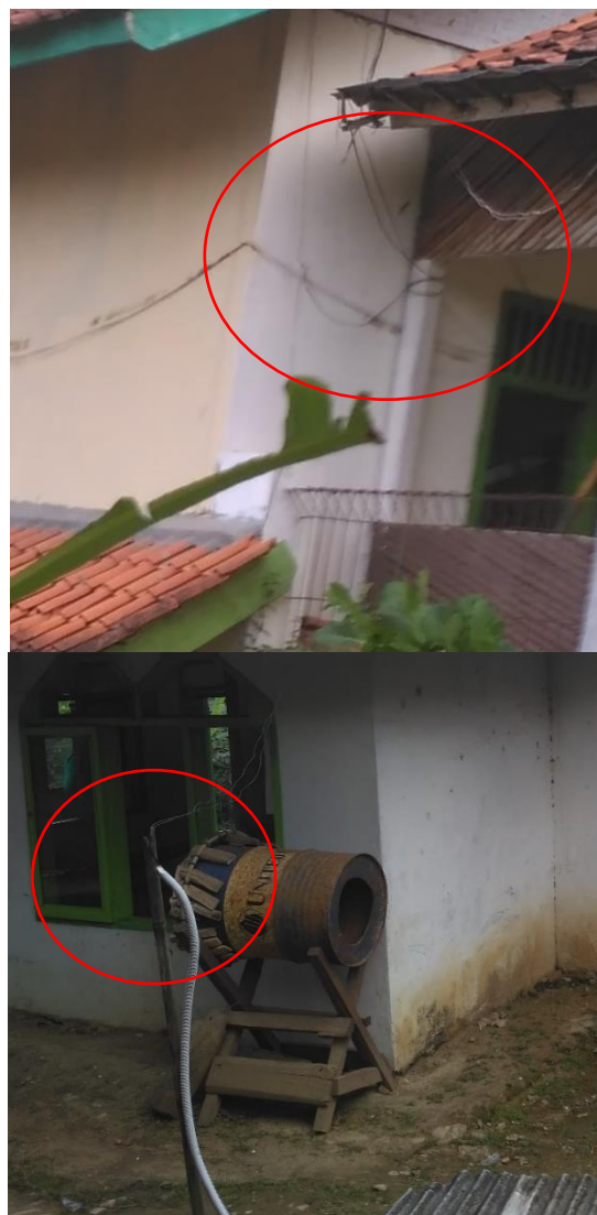
Gambar 3. Contoh Temuan-temuan Instalasi Listrik di Sekitar Pesantren yang Berpotensi Bahaya
